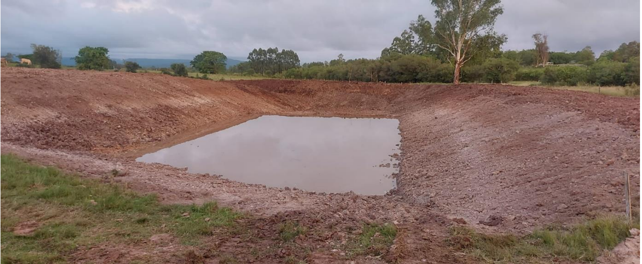
Foto da obra concluída (I):
