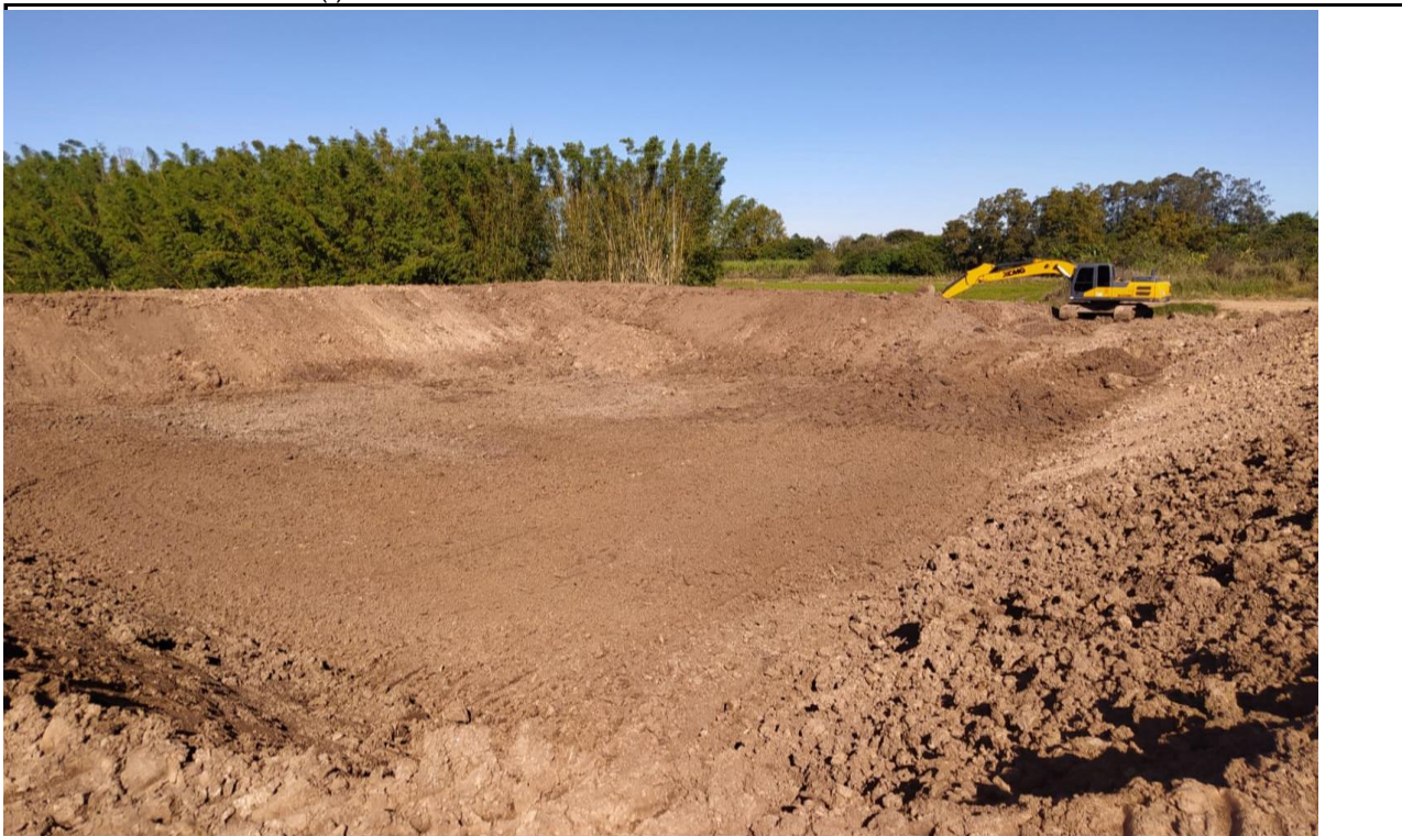
Foto da obra concluída (I):
