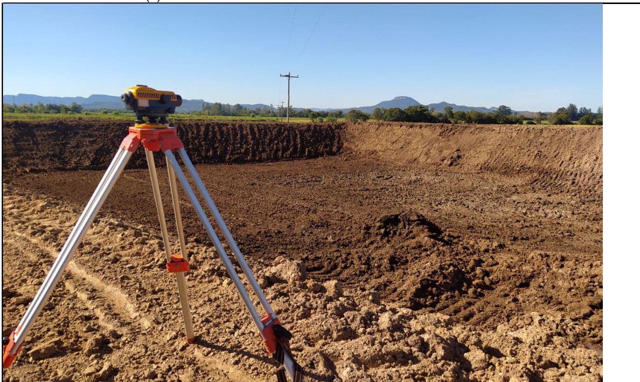
Foto da obra concluída (II):
