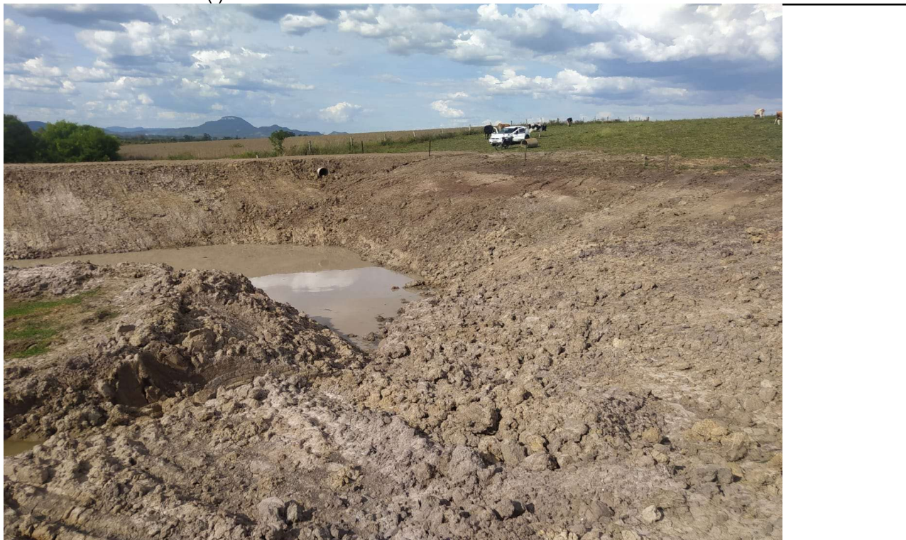
Foto da obra concluída (I):
