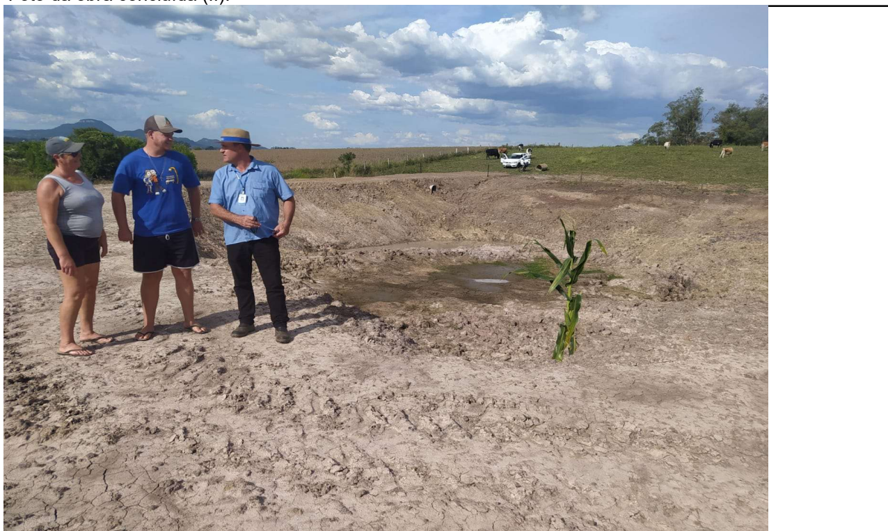
Foto da obra concluída (II):
