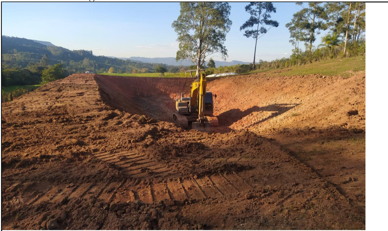
Foto da obra concluída (I):
