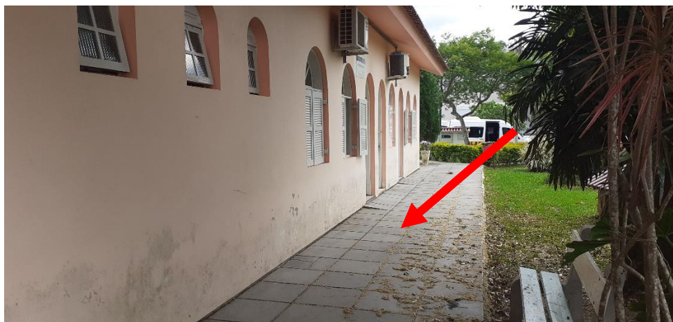
Figura 22: Piso a ser removido. Acesso lateral para a Prefeitura.
